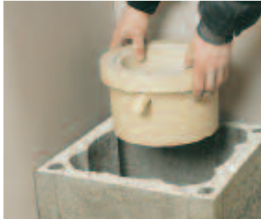
Plasser kondenspotten i ytterelementet.
